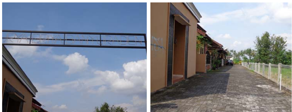
Gambar 7. Lokasi perumahan yang tidak sesuai mekanisme perijinan
