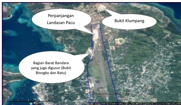
Gambar 1: Gambaran Umum Posisi Lokasi Pengadaan Tanah dan Penggusuran. Sumber: Citra Goole Earth
