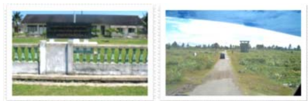
Laboratorium DENZIBANG TNI AD Bangunan fasilitas TNI AD
