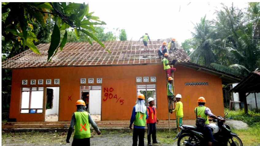
Gambar 22. Pembongkaran, Tahap Awal Pembangunan YIA Sumber: Hasil Pengolahan Data Primer oleh Peneliti, Juni 2017
