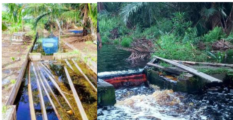
Gambar 3. Pola tebat (sekat kanal) yang dibangun di berbagai desa atas dukungan Badan Restorasi Gambut (BRG) terbukti efektif untuk mengurangi bencana kebakaran.
