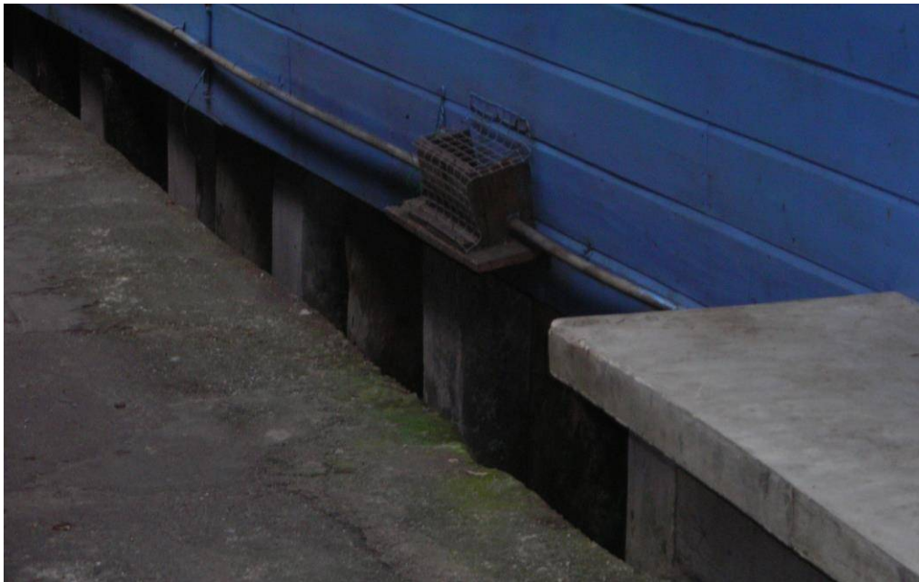
Gambar B. Tiang pancang beton penyangga bangunan
