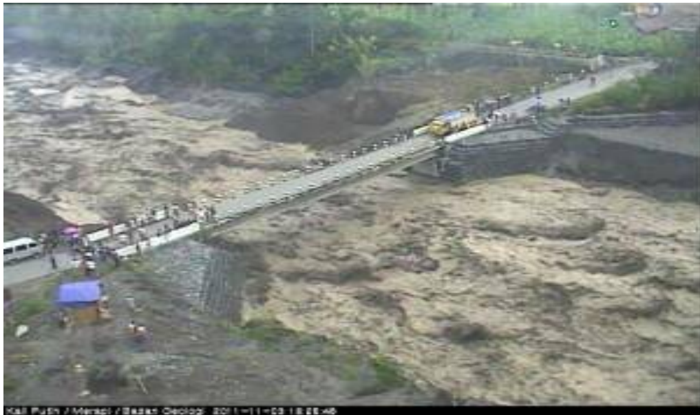
Gambar 14. Banjir Lahar Dingin Melewati Jembatan Ngepos
