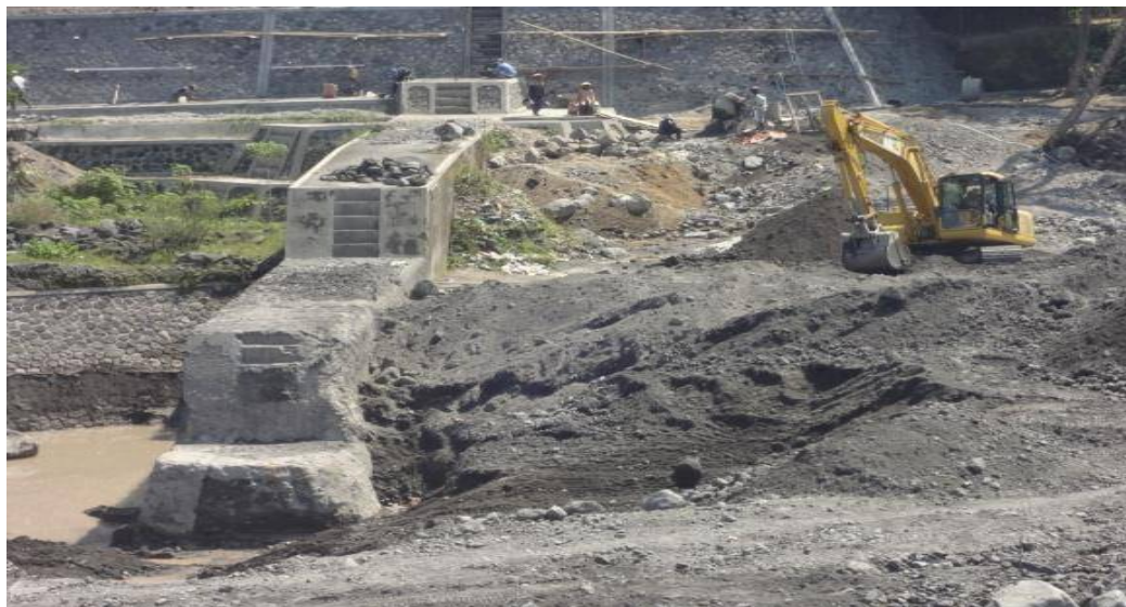
Gambar 30. Proyek Perbaikan Tanggul dan Cekdam Kali Putih
