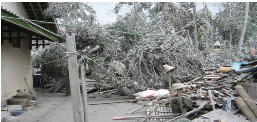
Gambar 20. Bangunan Rumah yang Rusak
