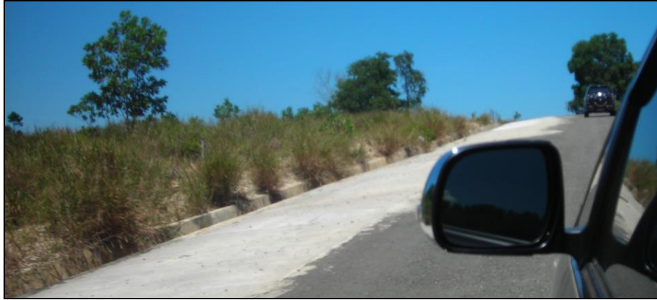
Gb. VI-5. Pelebaran Jalan dan Pembuatan Drainase di Mamburungan
